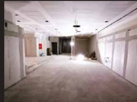
DIREÇÃO DE OBRA DIRECCIÓN DE TRABAJO
